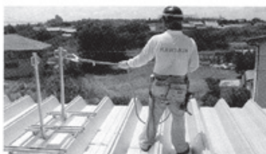
⑦親網のフックを支柱の取付ピースに掛ける。
