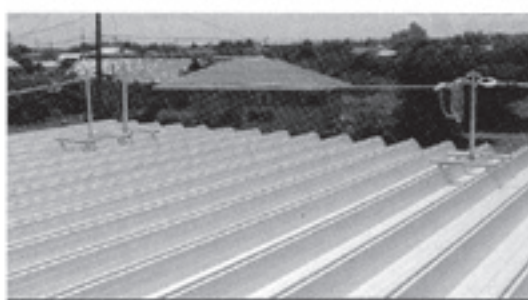
⑦親網のフックを支柱の取付ピースに掛ける。
