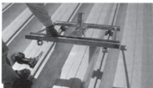
①支柱ベースを仮置きする。その時に、ハゼ金具のナットをインパクトレンチで緩めておく。
