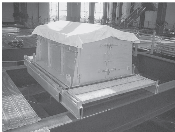
布板を敷きステージを梁の上に移動
