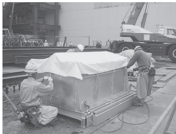
雨養生のためのシートを設置
