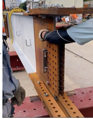
2. 通した丁番アシスト本体にプレートを取り付ける
