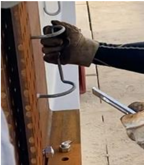
1. 丁番アシスト本体をスプライスプレートのボルト穴に通す
