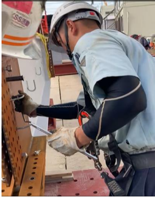
1. 丁番アシスト本体をスプライスプレートのボルト穴に通す
