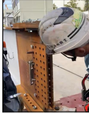
1. 丁番アシスト本体をスプライスプレートのボルト穴に通す
